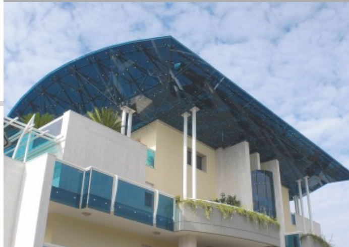
Residenza i Cristalli, Italien Module: 54 VSG 8/8 Abmessungen: 1.500 x 1.500 mm Leistung: 12 kW p
