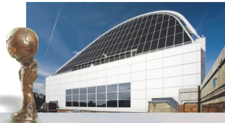
The Peak, London Module: 133 VSG Module in 37 verschiedenen Typen Abmessungen: max. 1.180 x 1.1700 mm, Leistung: 34,4 kW p
