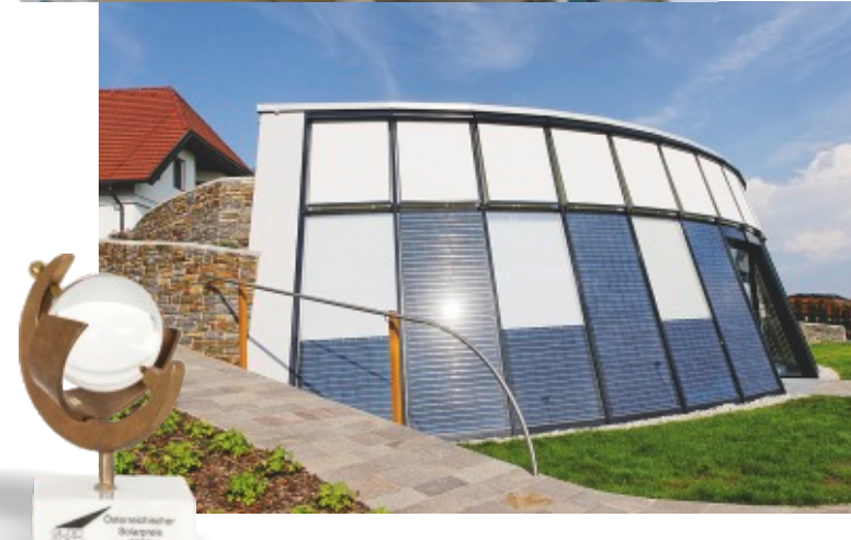
Familie F, Österreich Module: 17 VSG-ISO Abmessungen: 1.318 x 3.134 mm, Leistung: 6,3kW p
