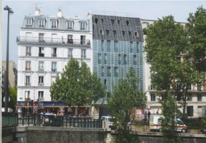
Quai de Valmy, Paris Module: 139 VSG 6/6 Abmessungen: 70 verschiedene Typen Leistung: 15,5 kW p
