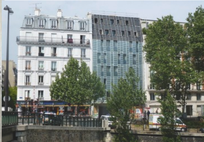
Quai de Valmy, Paris Modules brise-soleil Modules: 139 LSG 6/6 Dimensions: 70 types différentes Performance: 15,5 kW p
