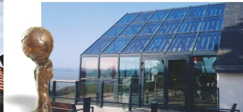
Maison de la Baie, Saint Brieux Cedex Modules: 36 LSG-ISO 132 W p Dimensions: 927 x 1.530 mm, Performance: 2,3 kW p
