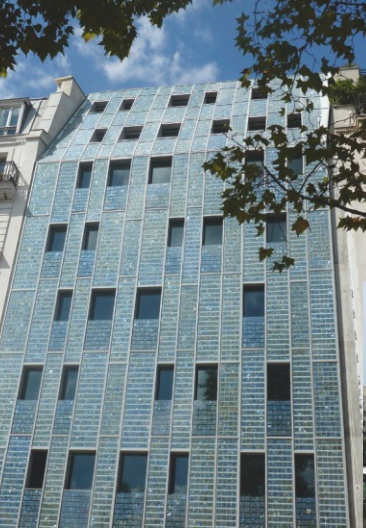
Quai de Valmy, Paris Modules brise-soleil Modules: 139 LSG 6/6 Dimensions: 70 types différentes Performance: 15,5 kW p
